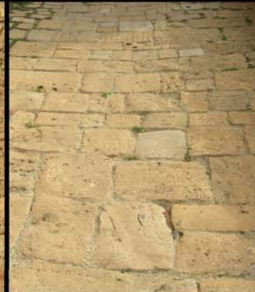
pavimentazione in pietra arenaria
