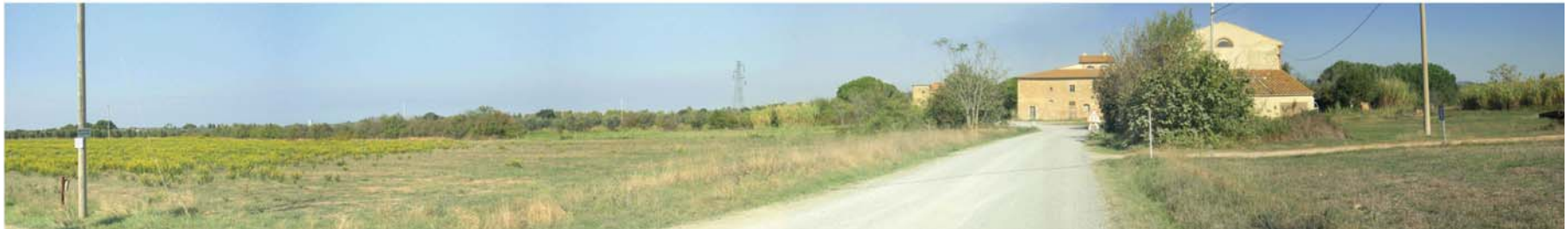
Foto stato di fatto: Podere Calcinaiola da Via dei Poggiali
