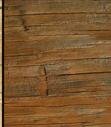
rivestimento pannello in legno
