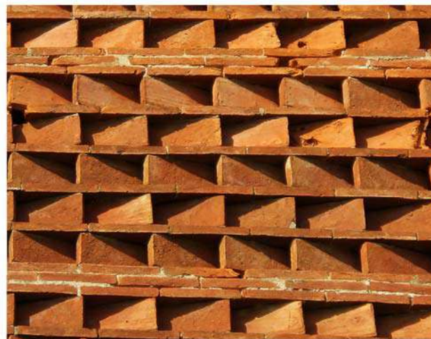
Particolare delle gelosie
