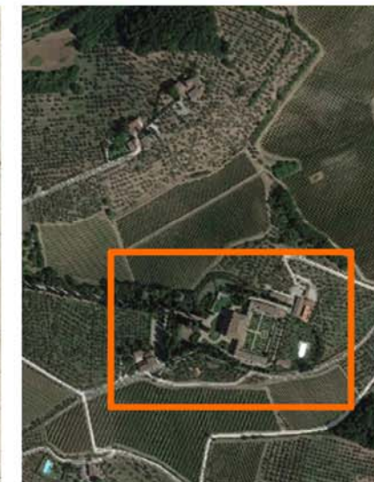
ortofoto stato attuale_agosto 2013
